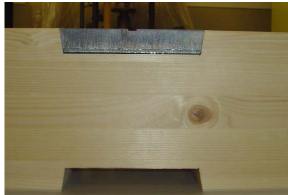
Abb. 2: Konventionelle Fugenausbildung mit direktem Kontakt zwischen stählerner Dübelleiste und Holz (Serie E)
