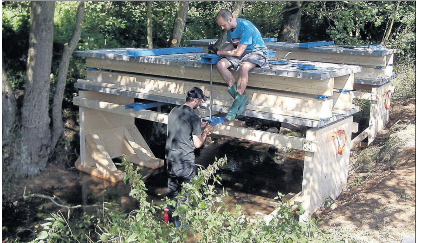
Kleben statt schrauben: Die studentischen Mitarbeiter Niklas Rieckmann (auf der Brücke) und Christian Bauer beim Aufbau der Brückenkonstruktion aus Holz und Beton über einem Bach in der Schwalm. Foto: Privat
